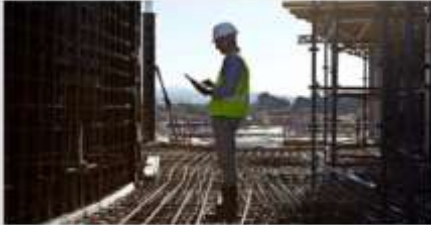
La construcción paraliza obras ante los retrasos en la llegada de materiales por la huelga del transporte
